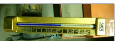
La température de stockage des 4 ballons est très élevée entre 72 et 76°C (voir photo). La température de départ a été relevée à environ 72°C par conséquent aucun risque de légionnelle n'est présent mais **une telle température de stockage et de distribution dans les réseaux induisent de pertes énergétiques très conséquentes.**
