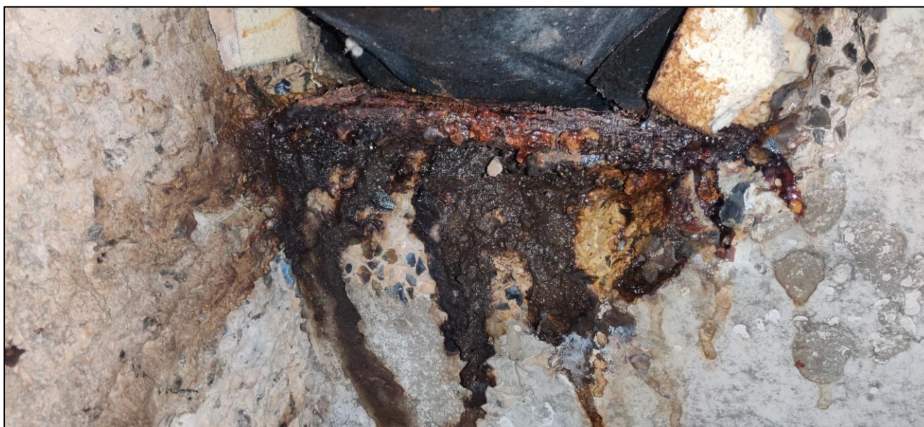
Photo de l'exutoire DN250 Fonte dans le local EAU et son état
