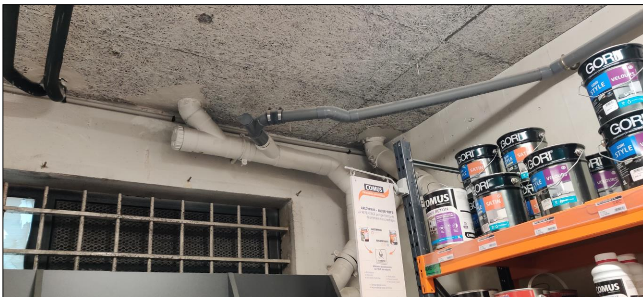
Photo du PVC Ø40 ayant un défaut de contre-pente
