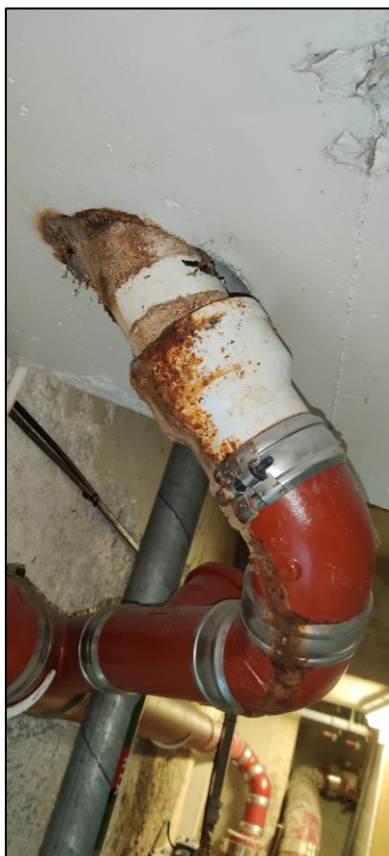
Photo d'une colonne en très mauvais état
