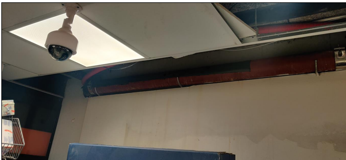
Photo de tronçons fuyards avec réparation de fortune
