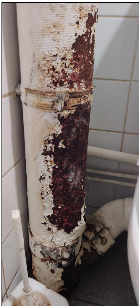
Photo de la colonne dans les WC en très mauvais état
