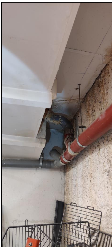
Photo d'une colonne fuyarde dans le local réserve
