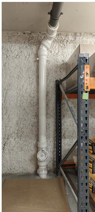
Photo de la nouvelle cannibalisation reprenant le quai de livraison avec finitions et se dirigeant dans le coude siphonide du le parking sous-sol -2 au 15/10/2024
