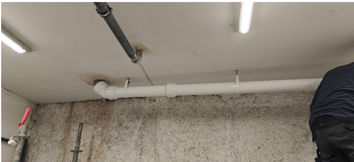
Photo des nouvelles canalisations posées avec finitions dans le parking sous-sol 2 au 15/10/2024
