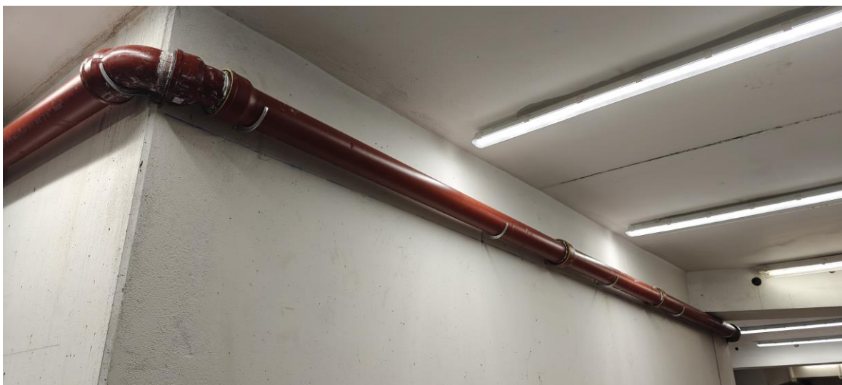
Exemple des nouvelles canalisations posées dans le parking sous-sol 2 au 08/10/2024
