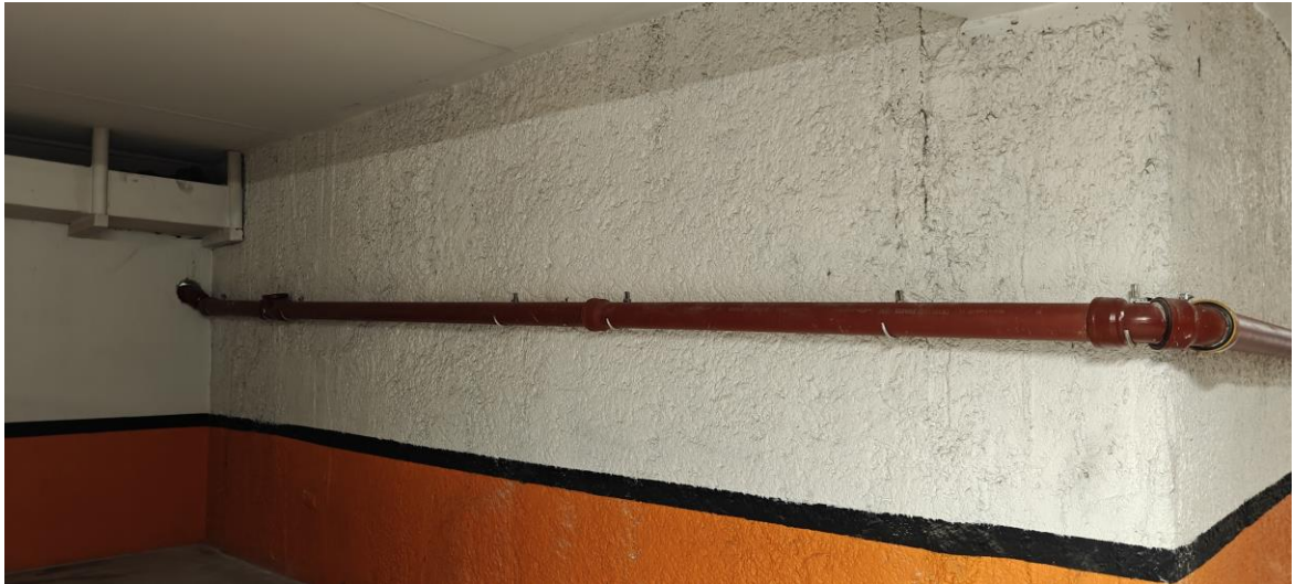
Exemple des nouvelles canalisations posées dans le parking sous-sol 2 au 03/10/2024
