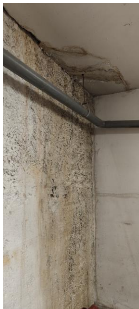
Zone de la fuite observée dans la réserve au sous-sol -2
