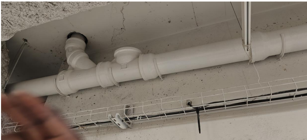
Photo des nouvelles canalisations posées avec finitions dans la réserve sous-sol -1 au 29/10/2024
