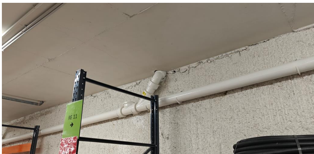
Photo des nouvelles canalisations posées avec finitions dans la réserve sous-sol -1 au 12/11/2024
