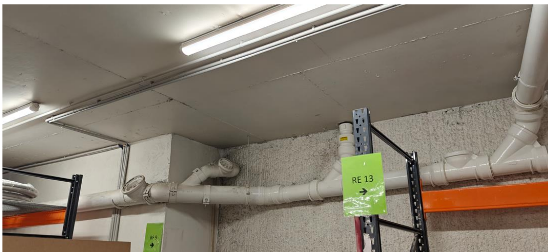
Photo des nouvelles canalisations posées avec finitions dans la réserve sous-sol -1 au 12/11/2024
