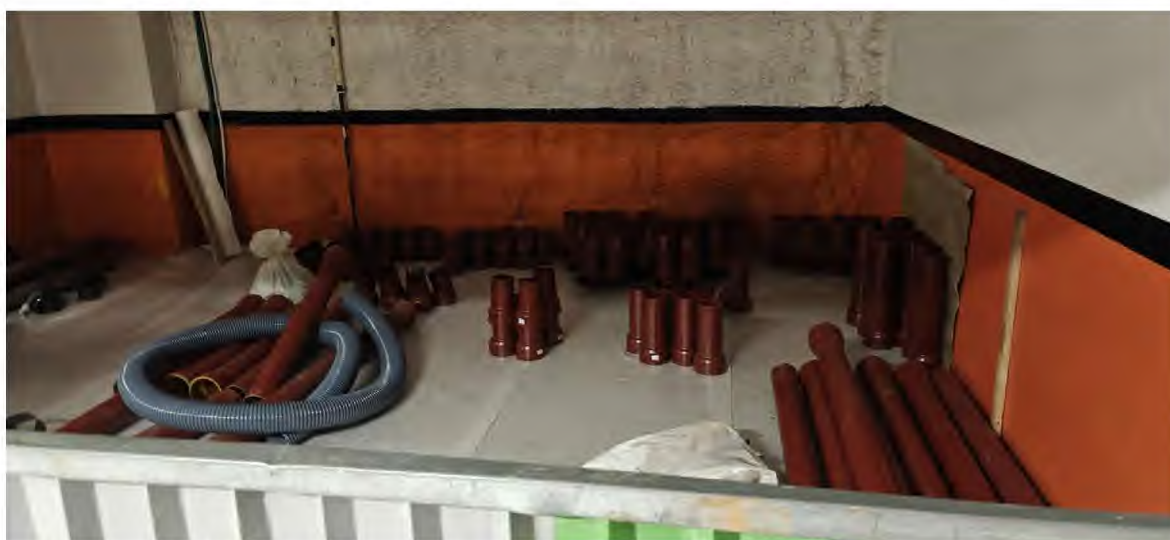
Balisage installé pour signaler l'espace de stockage des matériaux
