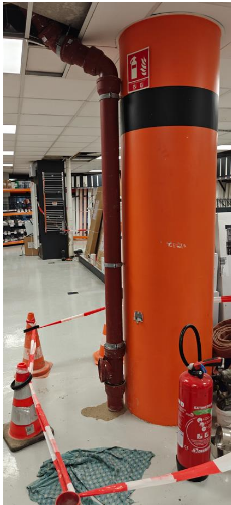
Photo des nouveaux Té de visite posés au 1 er Etage au 05/12/2024
