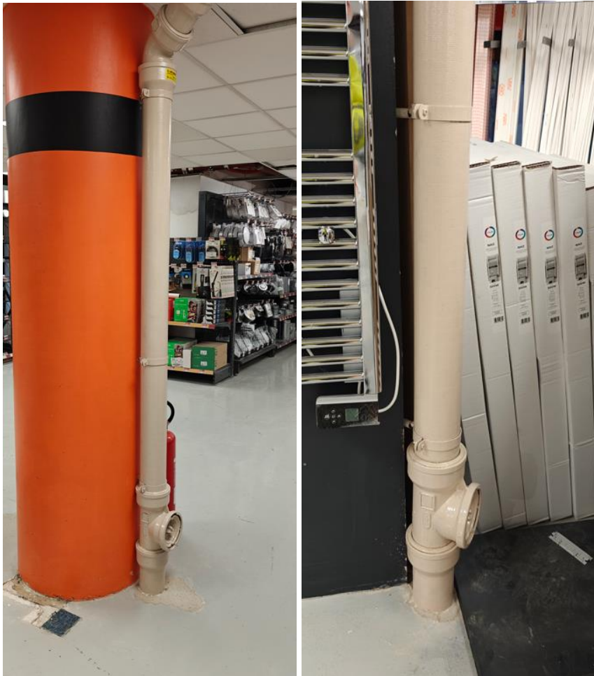
Photos des nouvelles canalisations posées avec finitions au 1 er Etage au 19/12/2024
