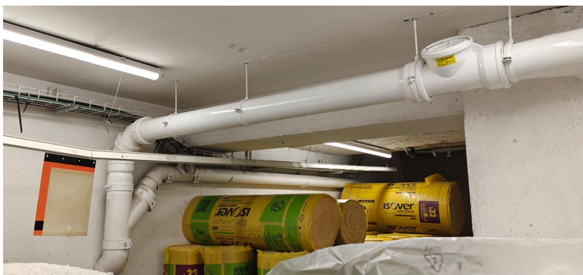
Photo des nouvelles canalisations posées avec finitions dans la réserve sous-sol -1 au 05/12/2024
