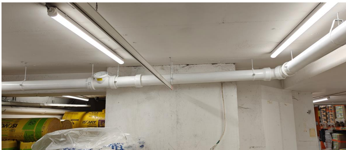
Photo des nouvelles canalisations posées avec finitions dans la réserve sous-sol -1 au 05/12/2024
