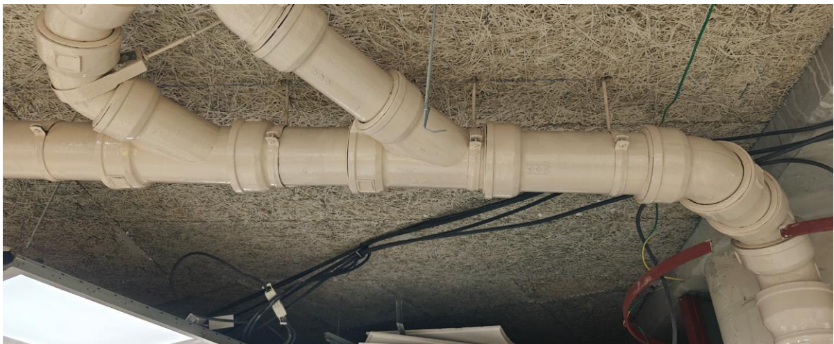
Photo des nouvelles canalisations posées avec finitions au 1 er Etage au 19/12/2024
