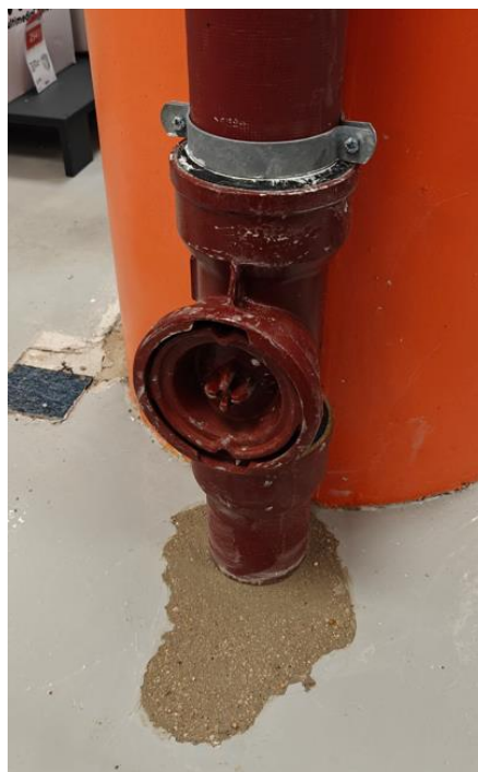
Photo des nouveaux Té de visite posés au 1 er Etage au 05/12/2024
