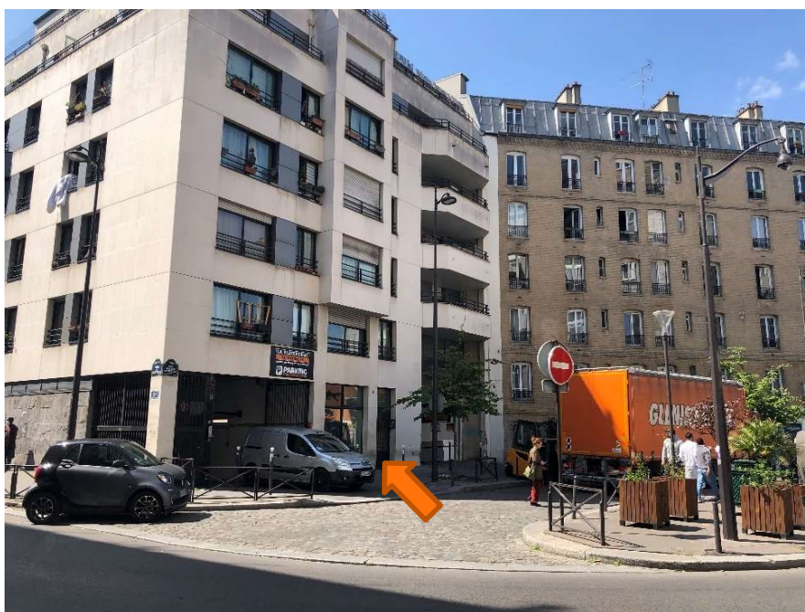
Façade sur la rue Gaston Rebuffat
