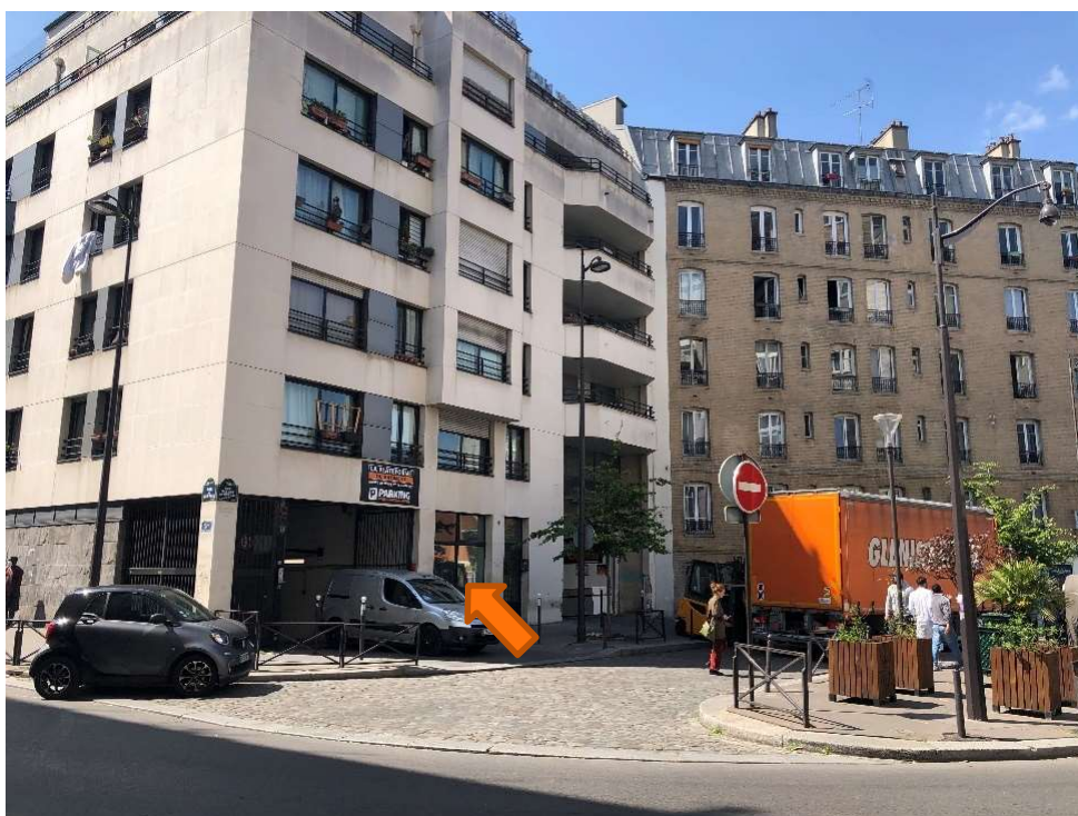
Façade sur la rue Gaston Rebuffat
