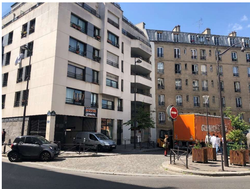
Façade arrière sur la rue Gaston Rebuffat
