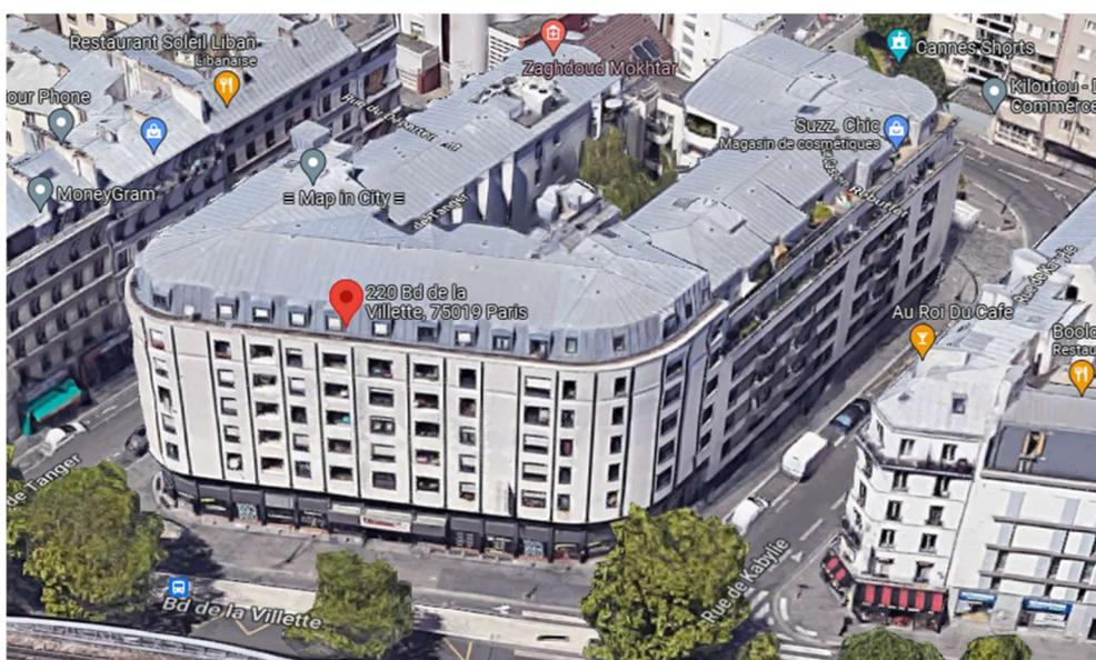
Structure béton avec façades de pierres agrafées en assez bon état de ravalement apparent.
