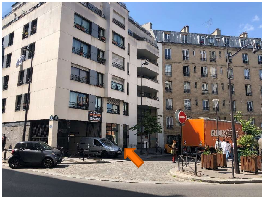
Façade sur la rue Gaston Rebuffat
