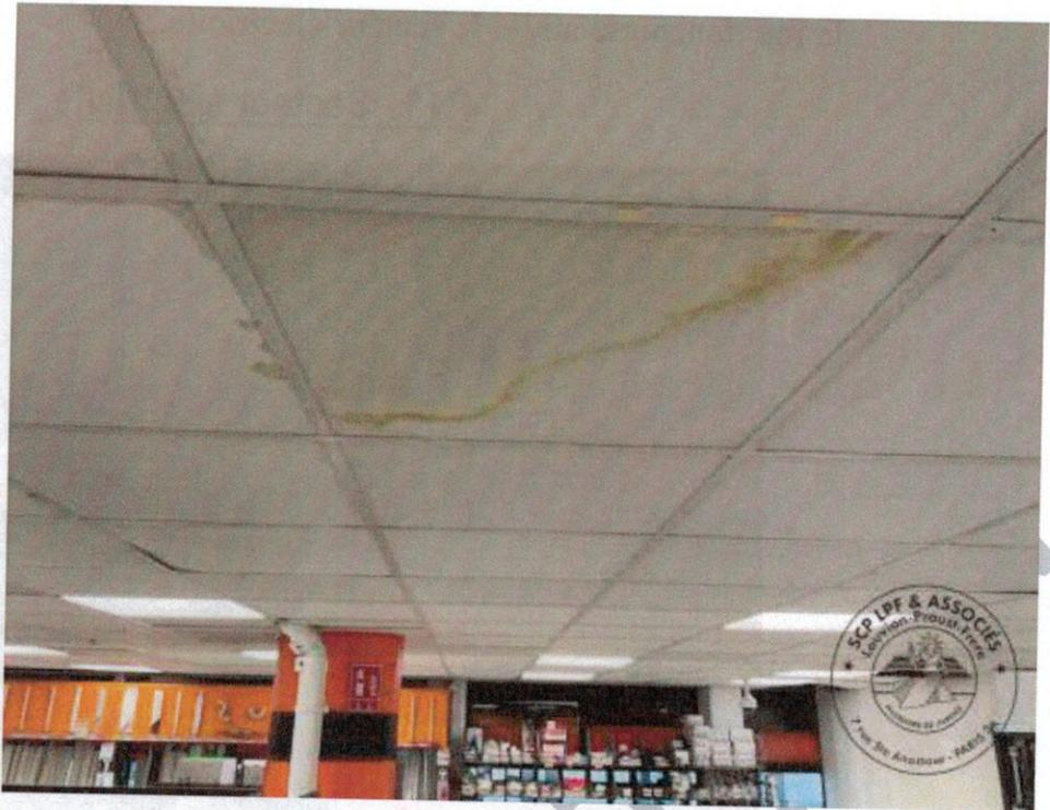
En plafond, des auréoles orange sont visibles outre des tâches et des traces de coulures sur les dalles montées sur châssis.
