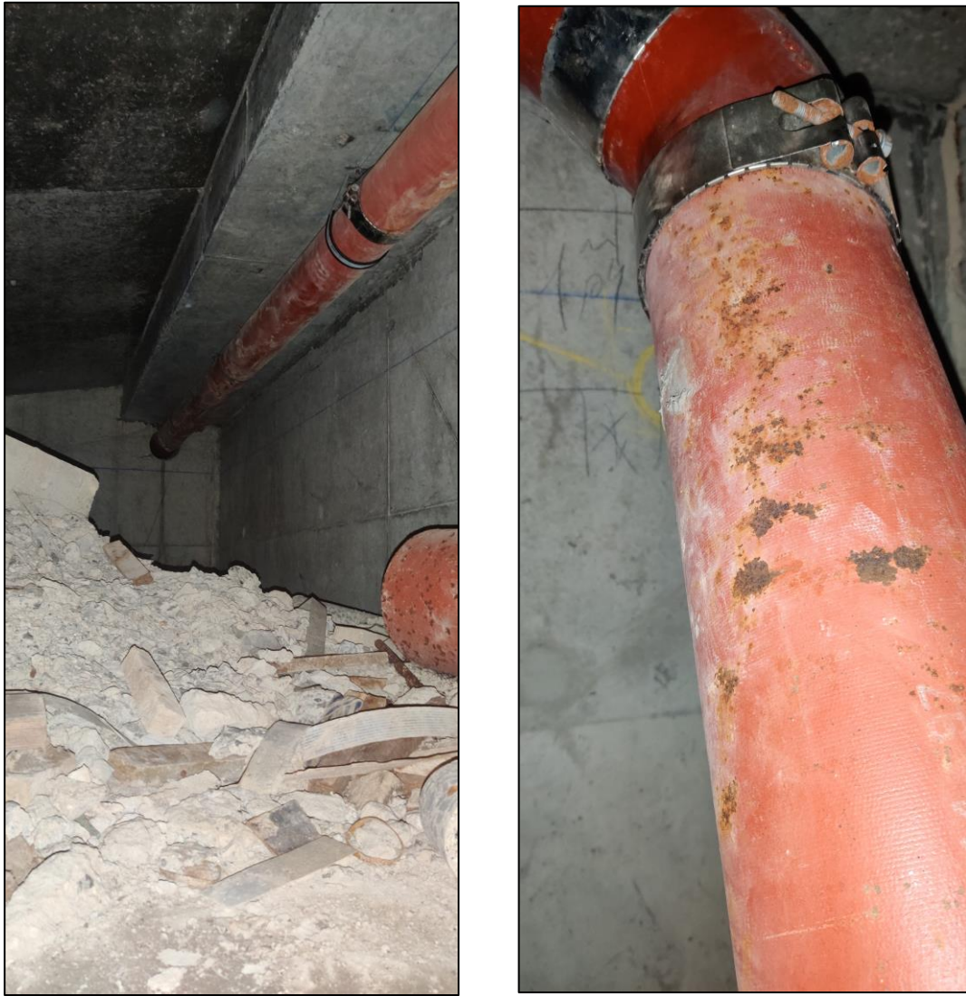
Photo du reste des tronçons corrodés dans le local EAU
