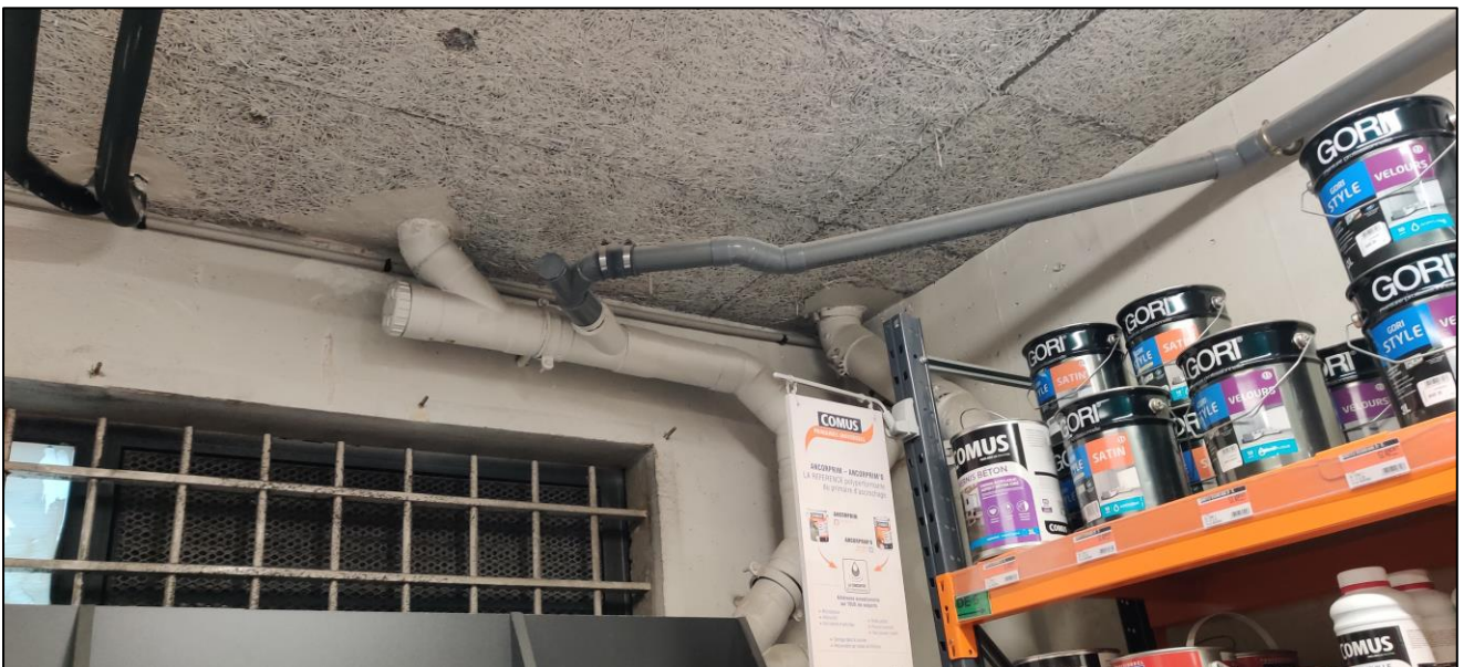
Photo du PVC Ø40 ayant un défaut de contre-pente
