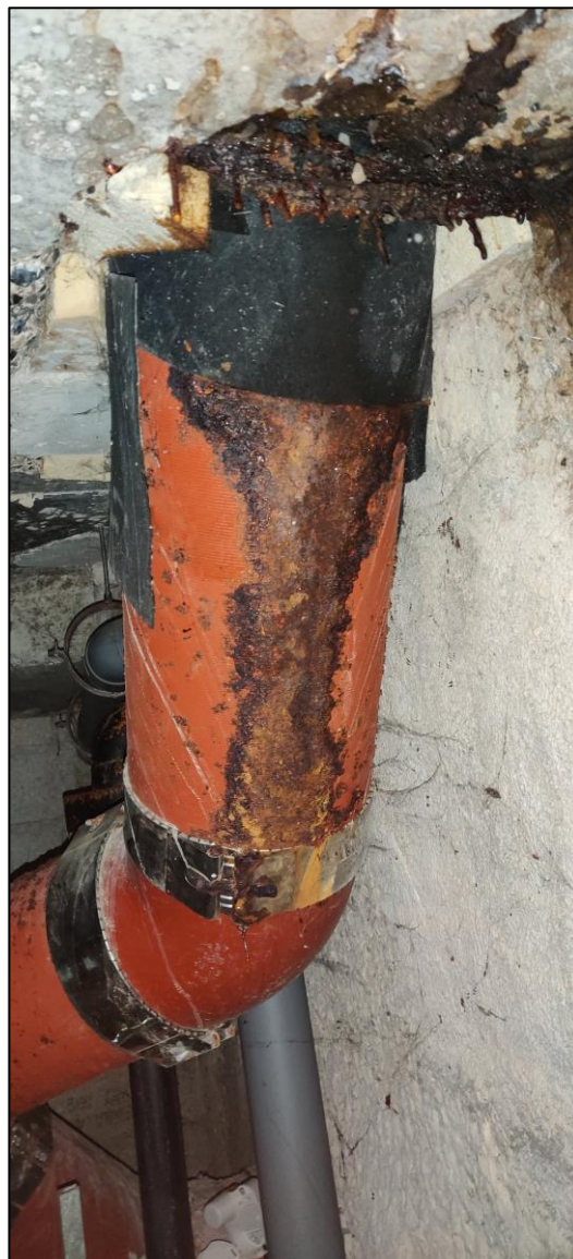
Photo de l'exutoire DN250 Fonte dans le local EAU et son état
