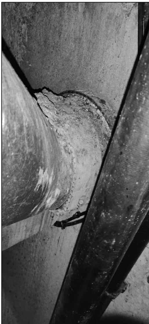
*Photo du reste des tronçons corrodés dans le local EAU*
