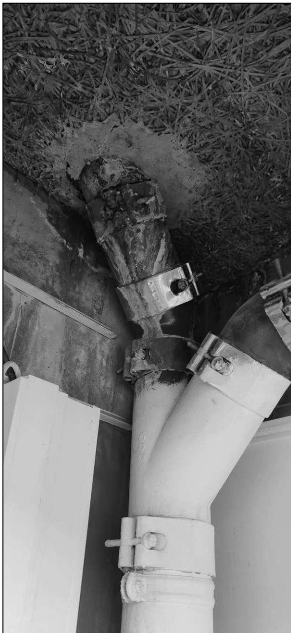
*Photo d'un tronçon fissuré dans les vestiaires hommes*
