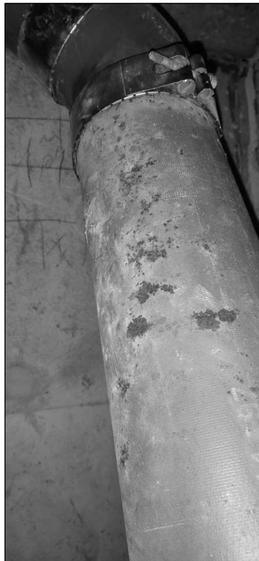
**Nota :** L'accessibilité à cette zone est limitée et se trouve en haut d'une échelle dans le Local EAU. De plus, il faudra veiller à une reprise soignée de l'étanchéité au niveau des entrées et sorties des fontes dans les dalles au vu de leur état d'après les photos.
