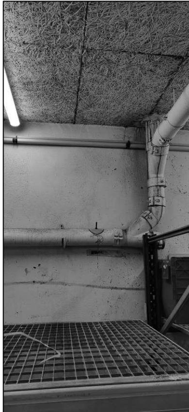
Photo d'une colonne en très mauvais état
