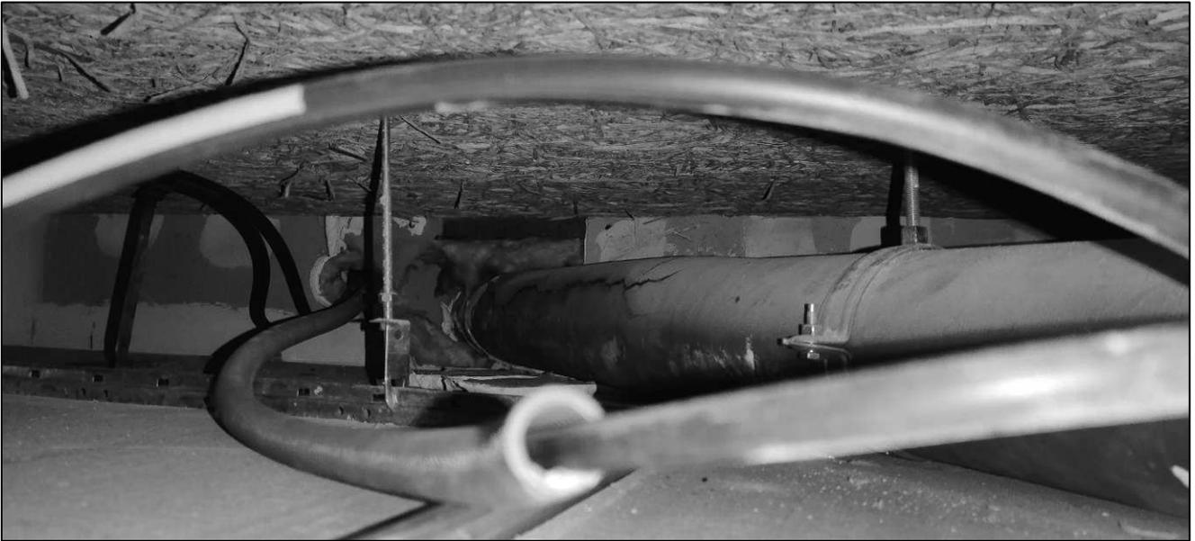
*Photo d'un tronçon fissuré dans les vestiaires hommes*
