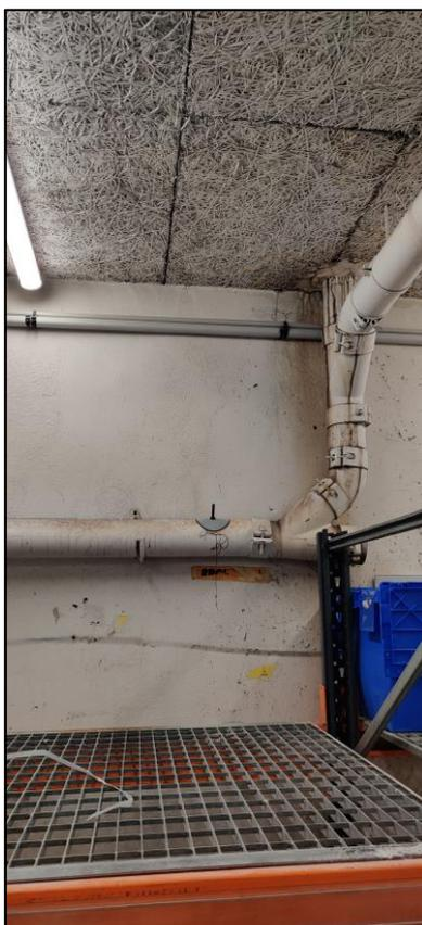
*Photo d'une colonne en très mauvais état*
