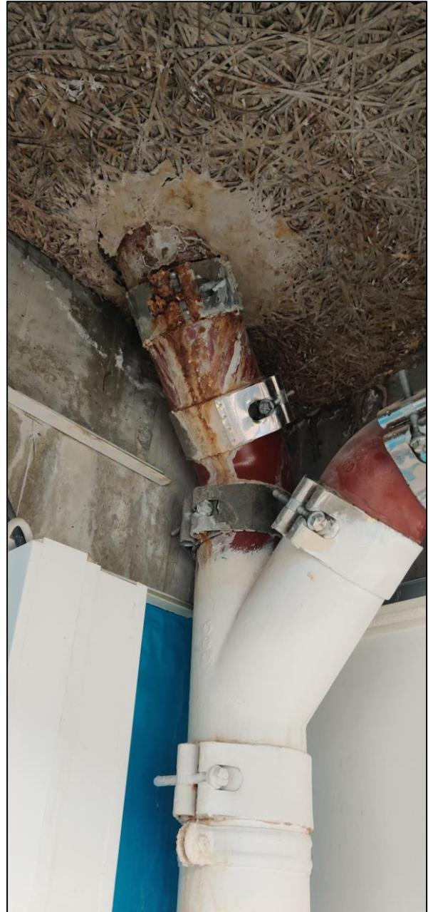
*Photo d'un tronçon fissuré dans les vestiaires hommes*
