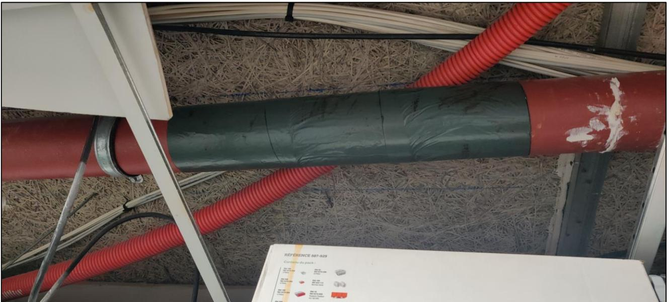
*Photos de colonnes fuyardes (à gauche dans le couloir près des vestiaires et à droite dans le local syndical)*
