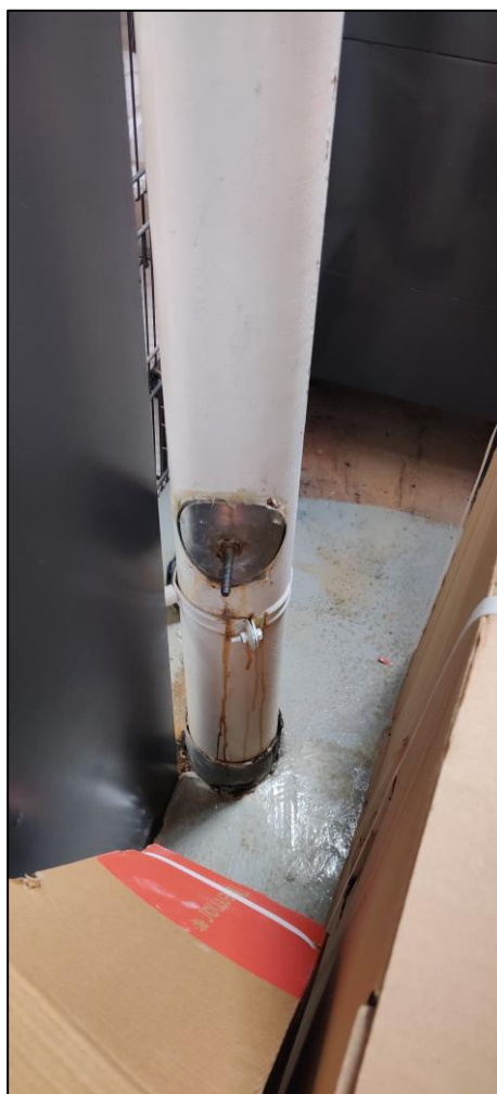
Photo d'une colonne avec un obturateur en guise de réparation
