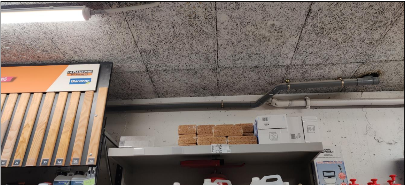
Photo d'un des tronçons ayant un défaut de contre-pente
