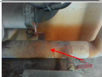
Photo n° PhA006 Localisation : Sous-Sol -1 - Local CPCU Ouvrage : Flocages, Calorifugeages, Faux plafonds Partie d'ouvrage : Calorifugeages Description : Calorifugeages Localisation sur croquis : M006
