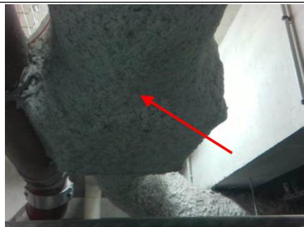
Photo n° PhA005 Localisation : Sous-Sol -1 - Local CTA Ouvrage : Flocages, Calorifugeages, Faux plafonds Partie d'ouvrage : Flocages Description : Flocages sur gaine de ventilation Localisation sur croquis : M005
